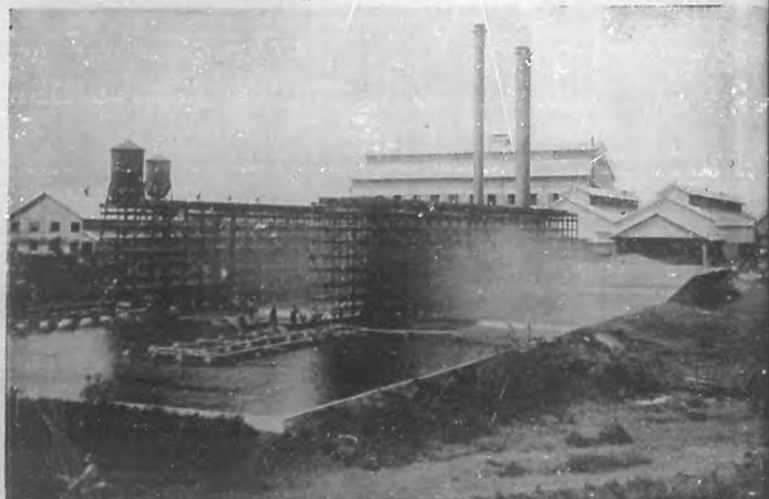
Vista de los refrigeradores y un costado del central "Manatí."
